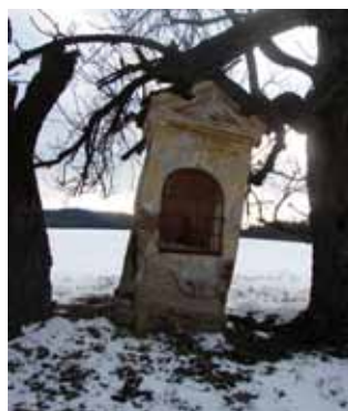
Kaplička před rekonstrukcí.
